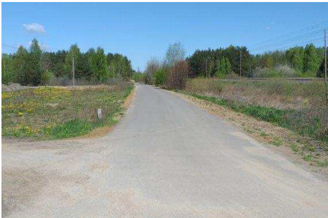
Fot.8 Przebudowana droga gminna we wsi Lewki (2019r.)
