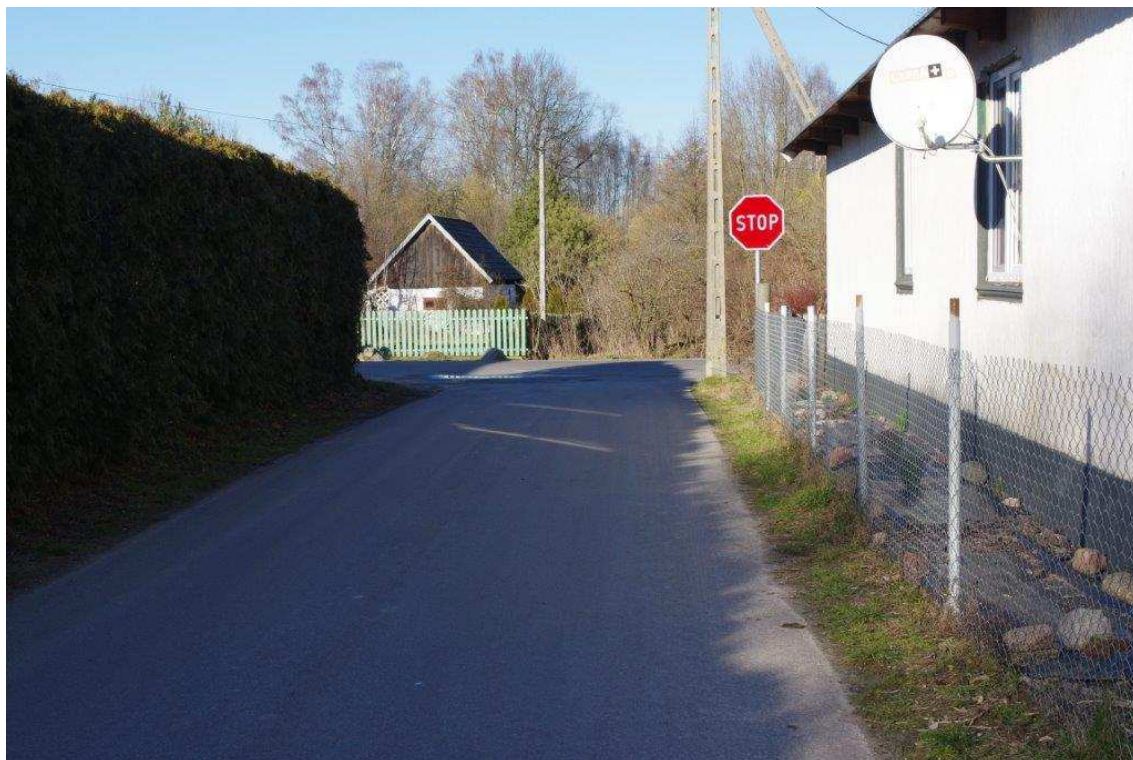
Fot.2 Przebudowana droga gminna nr 107457B Rajsk – Haćki (droga do budynku wielorodzinnego) (2019r.)
