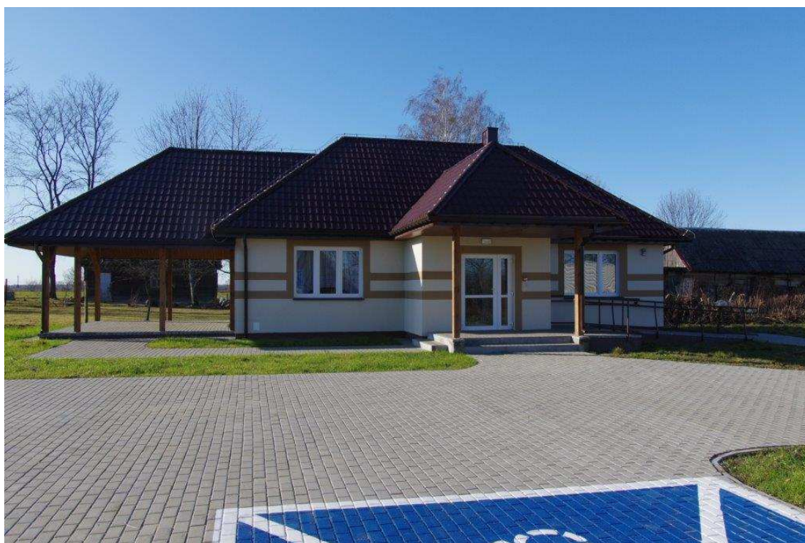
Fot.7 Przebudowana świetlica wiejska we wsi Kotły (2019r.)
